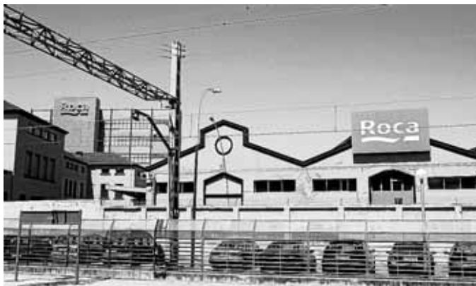
Fábrica de Roca Corporación en Gavá (Barcelona).
