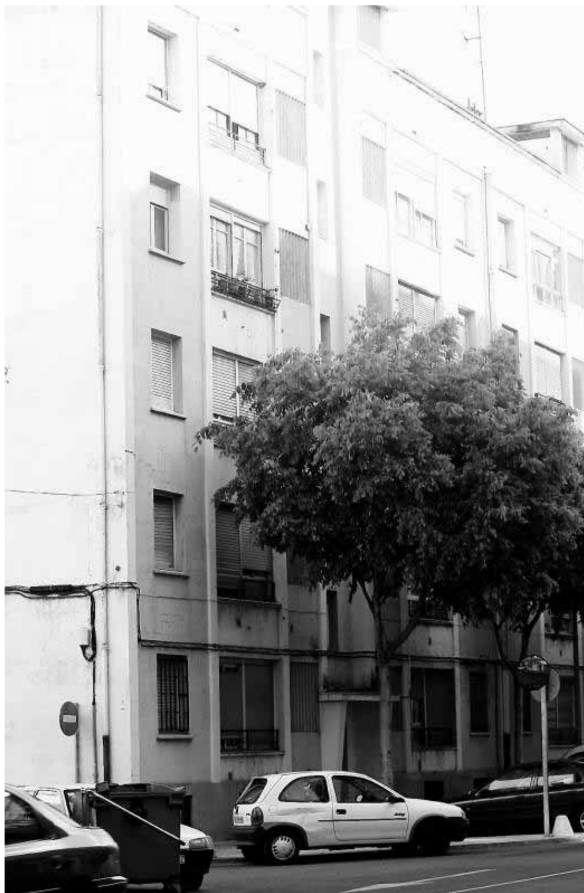
Piso de la avenida Almassora sobre el que se ha decretado un desahucio. ■ BELLIDO
