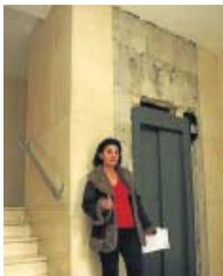
El ascensor de una vivienda.
