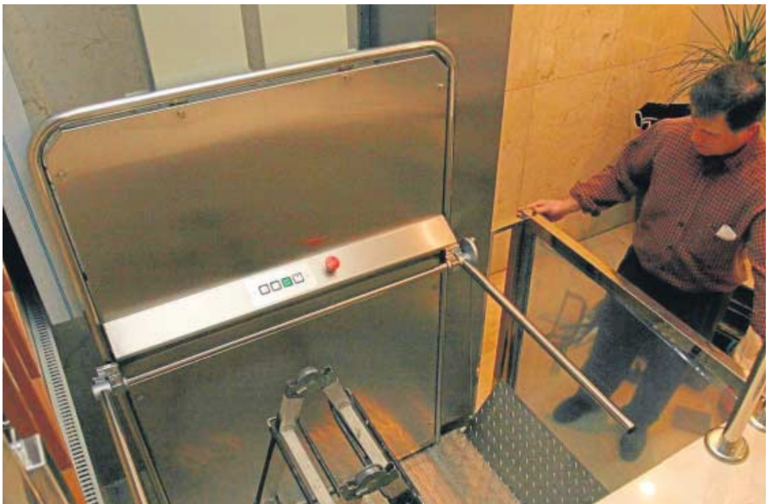
Un hombre arregla el elevador de una zona común de un bloque de viviendas en Málaga.
