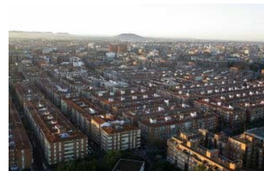
Vista aérea de la Rondilla, donde se han instalado ascensores en muchos de los edificios, una de las obras que generan impagos y enfrentamientos. :: GABRIEL VILLAMIL
