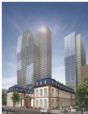
Torre Palais Quartier en construcción en Frankfurt, Alemania.
